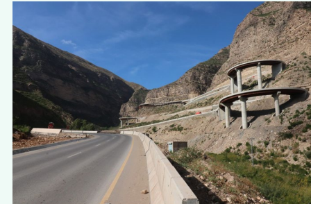
パキスタン国 国道70号線改良工事
