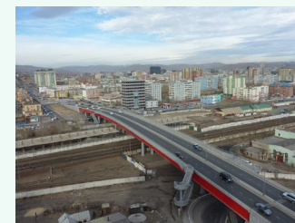
モンゴル国 ウランバートル市高架橋建設 計画で完成したナルニザム（太陽道路）
