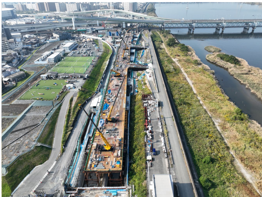
堤防一体型の道路工事に伴うCM
