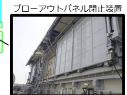
ブローアウトパネル閉止装置
