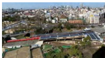
▲丸ノ内線四ツ谷駅の太陽光パネル
