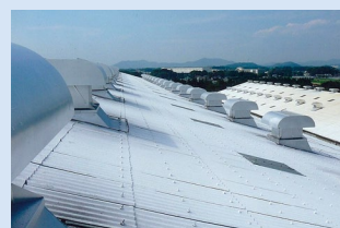
建屋・屋根改修
