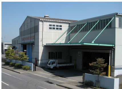
栃木コイルセンター 栃木県小山市
