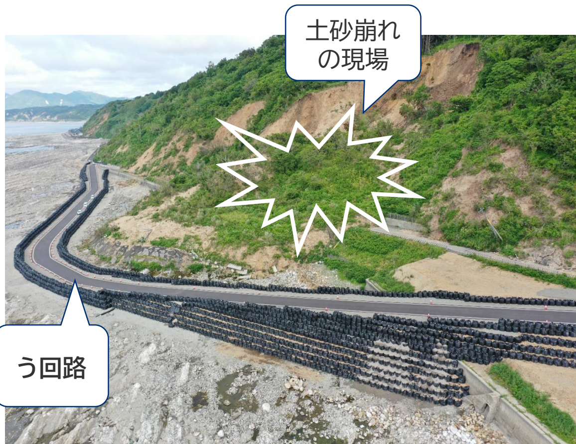
国道249号応急復旧工事
