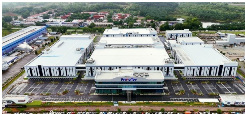
クリム第一工場 (マレーシア)
