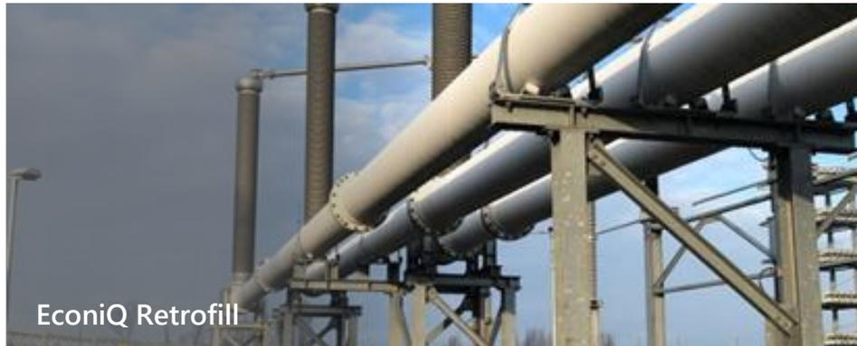
National Grid, UK ELK-3 / 420 kV GI (2016年設置) SF<sub>6</sub> を755 kg 削減
