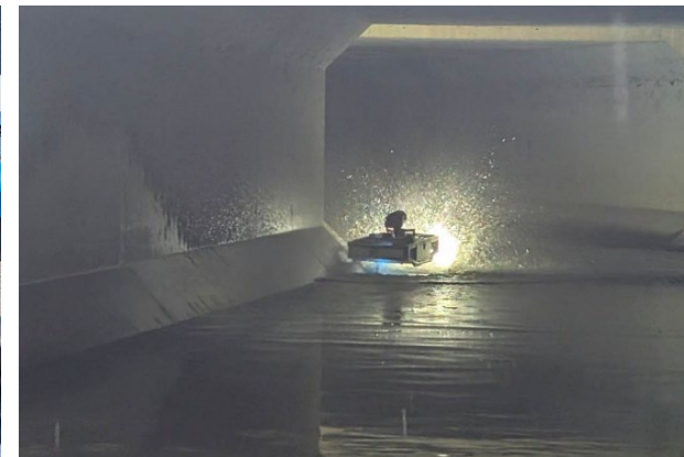
雨水管内を飛行するFi4 (3月3日境町にて撮影)
