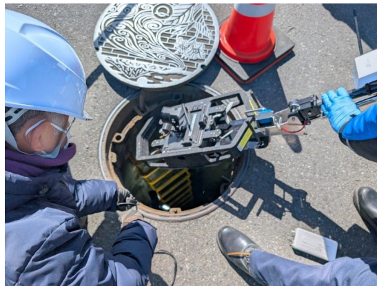
下水道管点検の様子(3月7日境町にて撮影)
