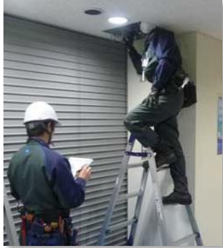
防火設備検査
