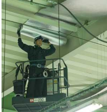
「はるクール」設置作業
