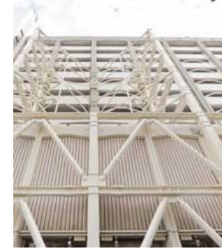
マンション耐震補強工事 (ビルリニューアル)
