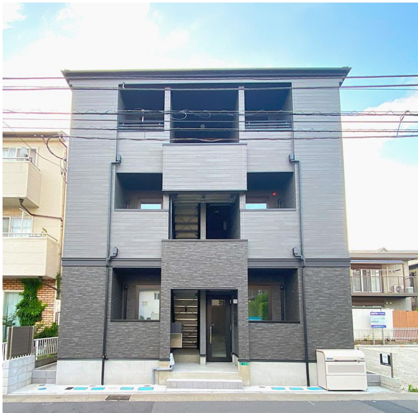
<投資用アパート施工事例 KLEIS古淵II>
