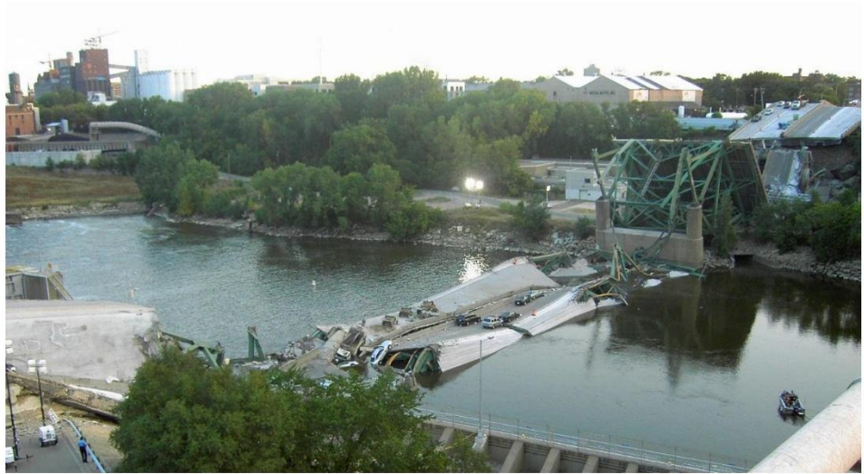
出所：2007年8月1日ミネソタ州で発生したミネアポリス高速道路崩落事故の様子（2007年8月2日 Mike Willis 撮影）
