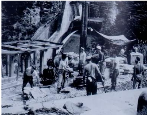
1963年 黒部ダム 電気工事完工
