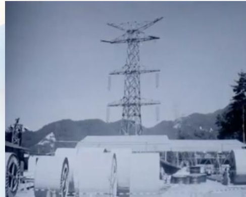
1988年 国内初100万ボルト送電工事受注
