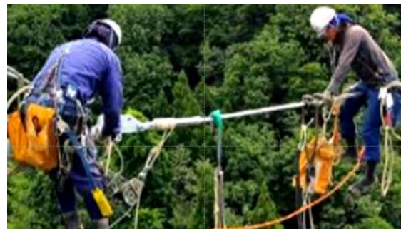
送電線架線工事の様子
