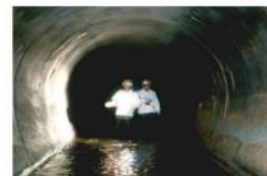
大口徑管路の潜行目視調査の様子
