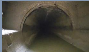
北九州市下水道ドローン調査
