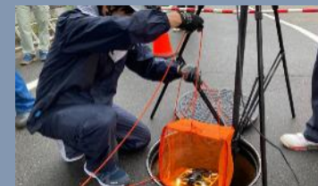
神戸市下水道ドローン調査
