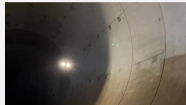
< 千葉市の雨水管内での実証実験の様子 >
