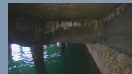
北九州市港湾栈橋のドローン点検
