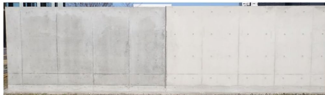
構築した壁部材の出来栄
