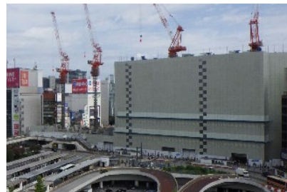
解体工事が進む旧・小田急百貨店新宿店本館
